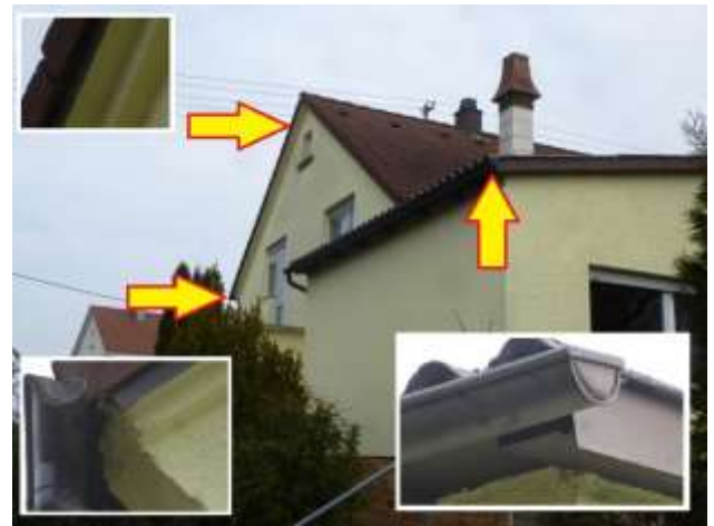
Abb. 5: Gebäude Auf dem Kies 2 ohne Nischen und Spalten im Dachbereich.
