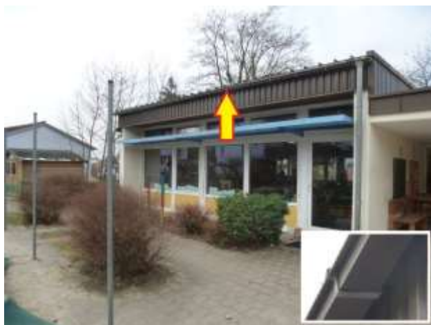
Abb. 2: Flachdach des Kindergartengebäudes mit seitlichem Randprofil ohne Spalten und Lücken.
