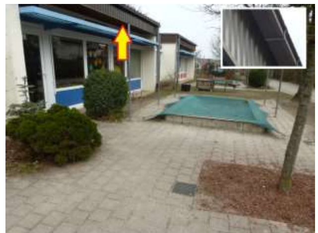
Abb. 3: Flachdach des Kindergartengebäudes mit seitlichem Randprofil ohne Spalten und Lücken.
