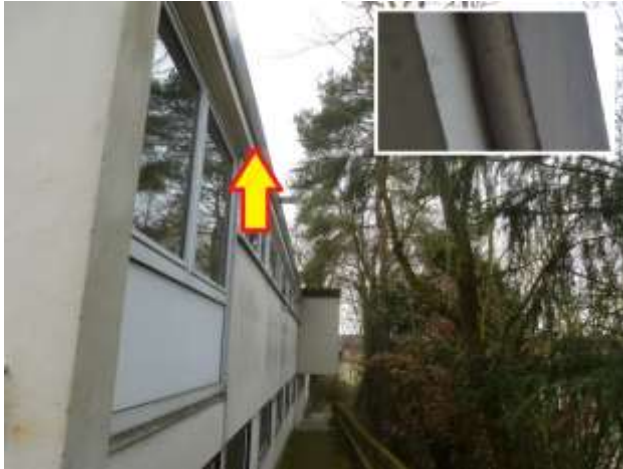
Abb. 4: Flachdach des Kindergartengebäudes mit seitlichem Randprofil ohne Spalten und Lücken.
